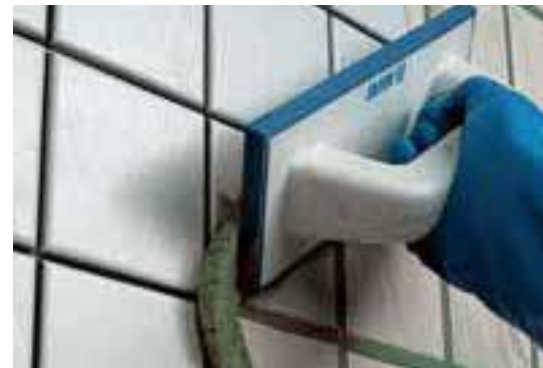
Wandverfugung mit Gummifugbrett
