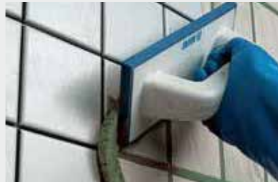
Hydratation der mit Spezialzementenformulierten Ultracolor Plus-Fuge (frei von Portlandzement und Calciumhydroxid, welches weißliche Ausblühungen verursachen kann)
