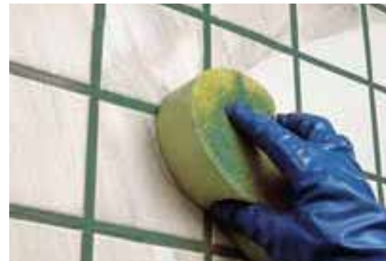
Waschen der Fuge mit einem Schwamm
