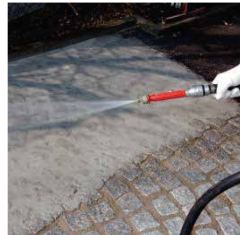
Anschließend erfolgt das Abreinigen mit dem Wasserschlauch. Um beim Reinigen der Pflastersteine ein Ausspülen der Fugen zu vermeiden, ist der Wasserstrahl nahezu horizontal zur Oberfläche zu halten.
