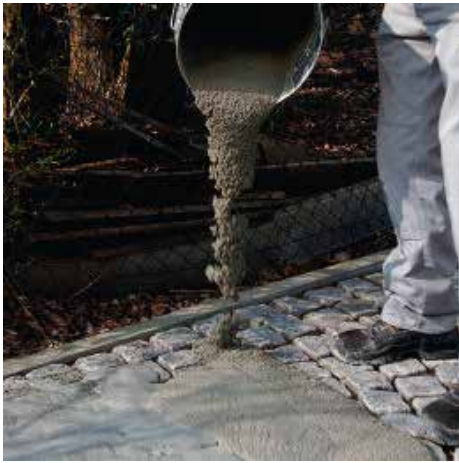
Aufbringen von PCI Pavifix CEM Rapid auf die sorgfältige vorgemastete zu verfugende Fläche.
