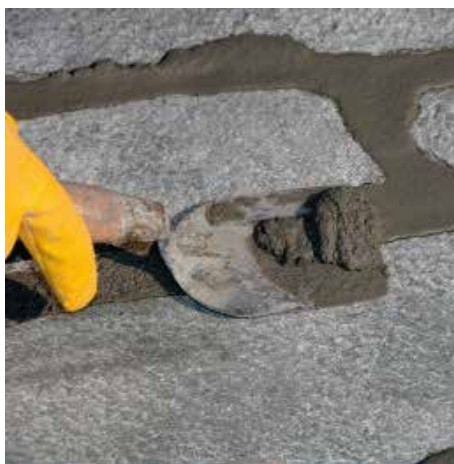
Nach Anziehen des Mörtels (Fingerkuppentest) Überstand mit einer Spachtel abstechen.
