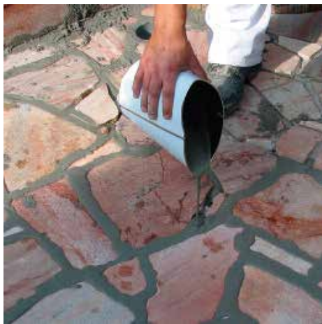
Pavifix CEM Rapid mit einem geeigneten Gießgefäß in die vorbereiteten Fugen einbringen.
