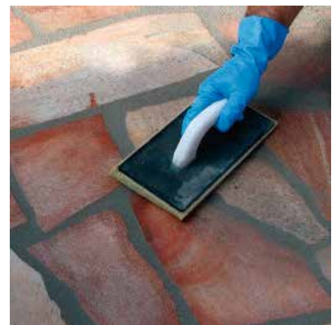
Anschließend Plattenbelag mit einem Schwambrett nachwaschen.
